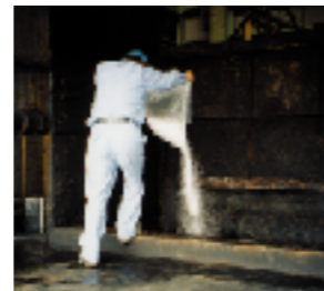
汚泥槽に投入
